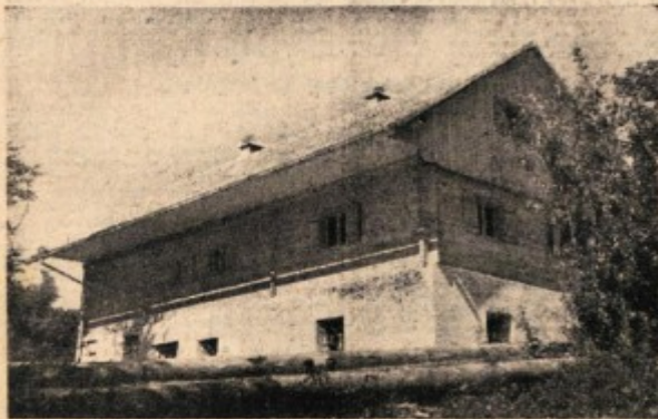
Obnovljena logarnica na Frati, ki bo v soboto 12. septembra 1952 popoldne slavnostno odprta, na njej pa odkrita spominska plošča.
