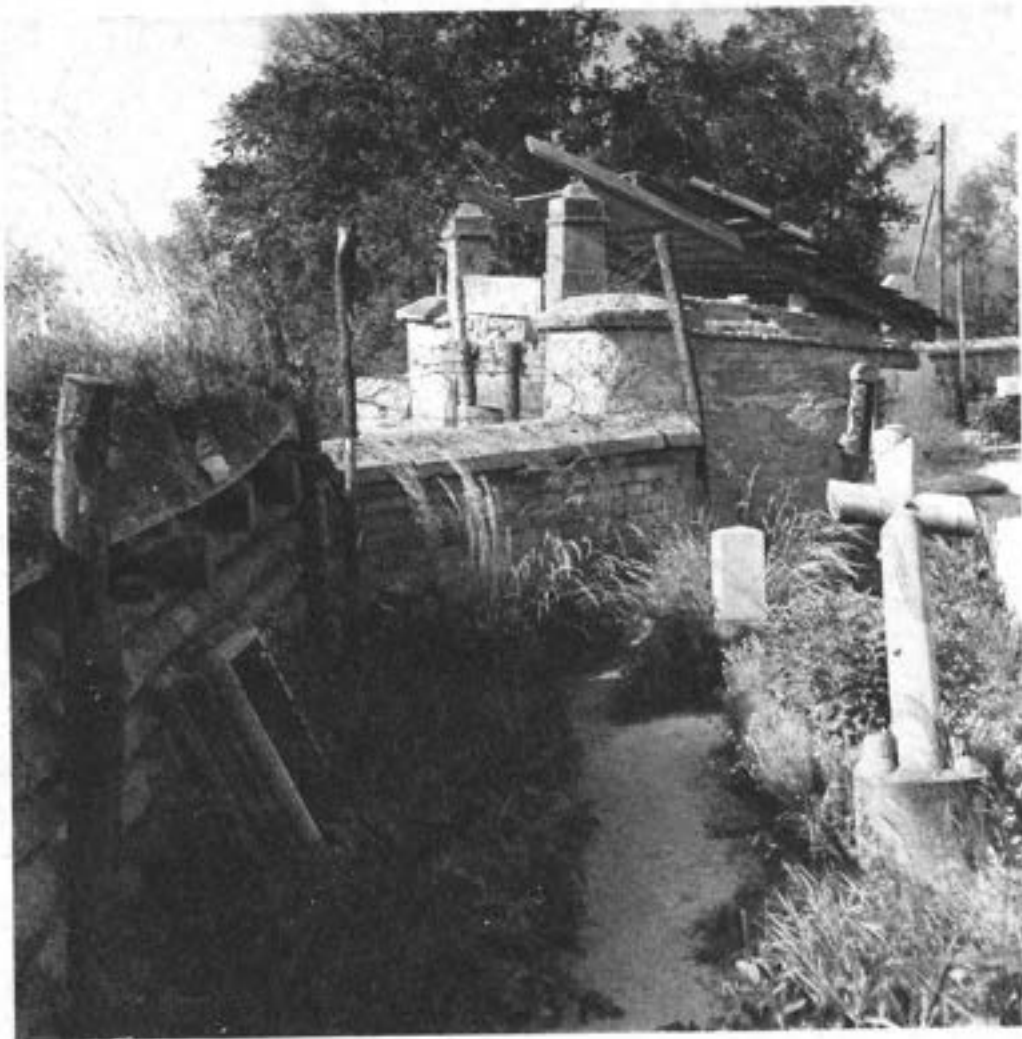
125. Bunker na pokopališču pri Sv. Urhu.
