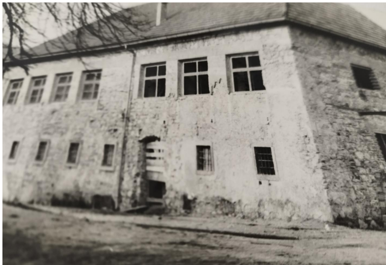
Grajska kašča med obnovo
