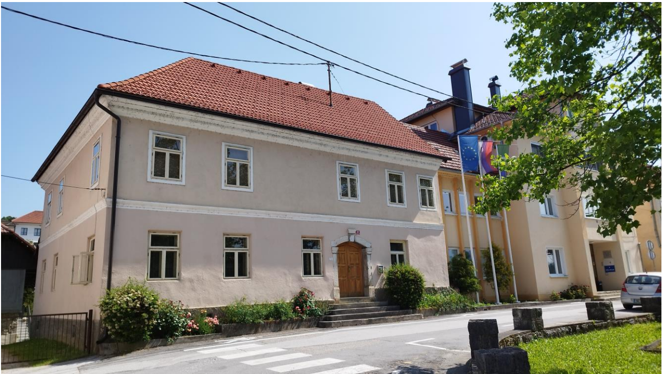
Smrketova hiša in stavba Občine Žužemberk
